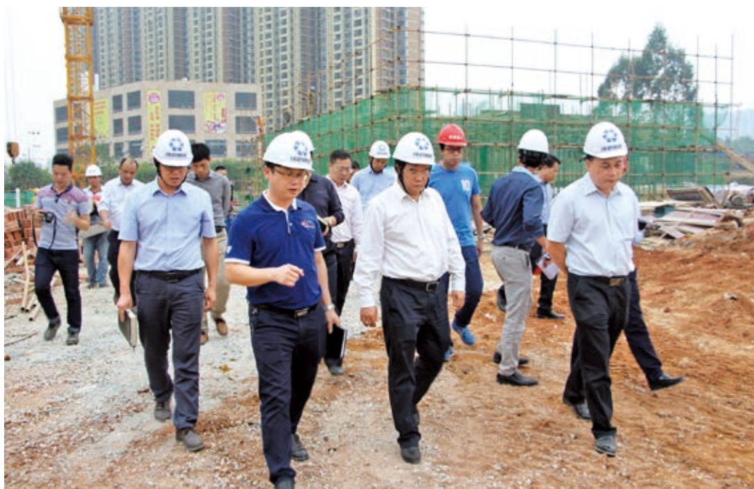
经开区党工委书记、管委会主任何尚汉一行抵达那洪沟项目现场检查指导工作
